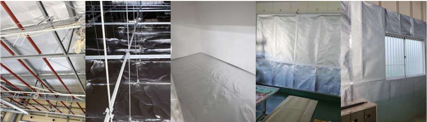
既存の屋根下 天井裏 保冷库の床 勝手口 壁面
