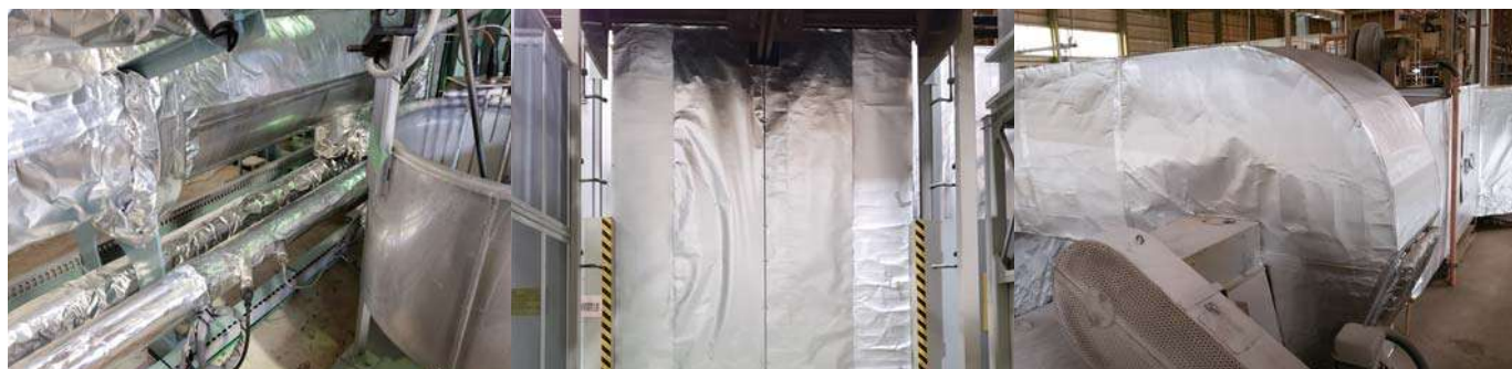
蒸気配管施工
