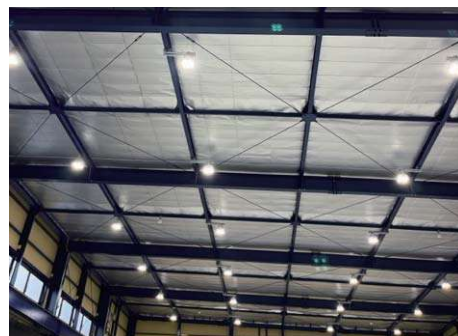
倉庫の屋根下
